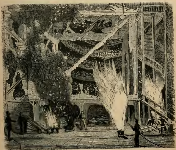
Fig. 51. — 2. Effet d'incendie, vu du fond du théâtre.
